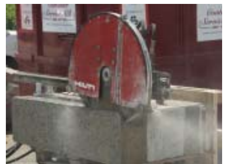
Demonstrationssågning med den nya väggsågen med elektronisk styrning.
